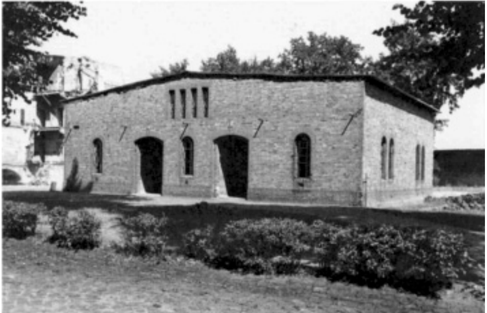
Bâtiment des exécutions, à l'arrière-plan les ruines du bâtiment III, vers 1950
