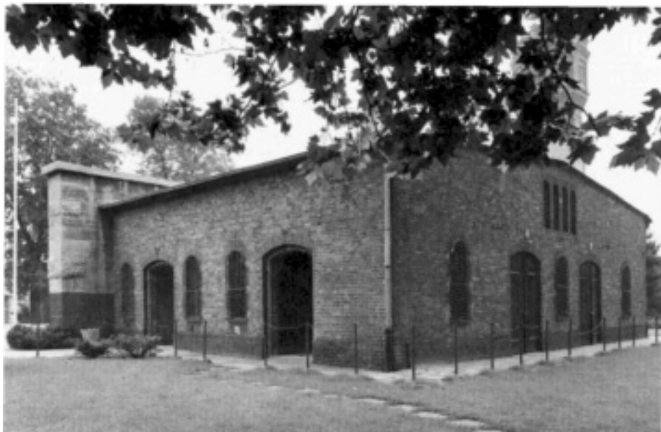
Le bâtiment des exécutions 1965
