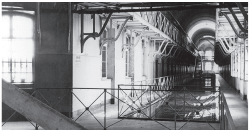
Gang D III mit den Zellen 537 bis 555 von der Mittelhalle aus gesehen
